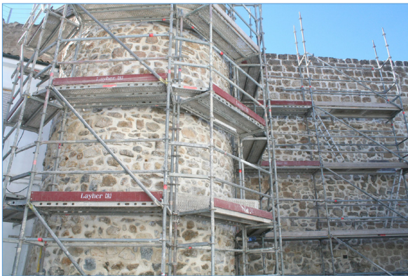
Castillo, AAPre. Torre T4 y lienzo L4 (parcial), en un estado muy avanzado de la intervención.
