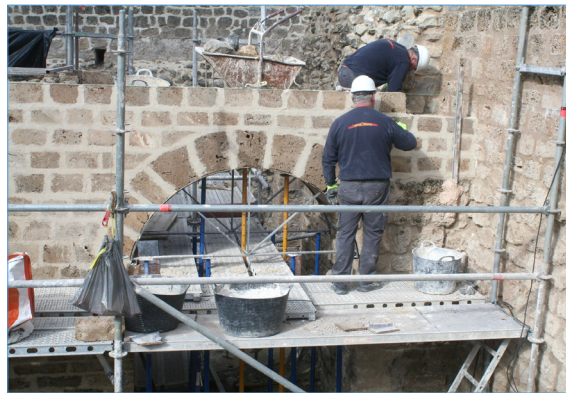
Castillo, AAPre. Reconstrucción parcial del acceso a la Zona 7 abierto en el lienzo L10.
