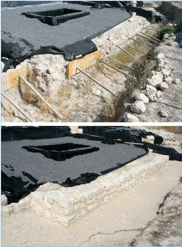
Cortijo de los Cipreses. Estado anterior y posterior a la intervención de urgencia realizada sobre estructura muy dañada del yacimiento.
