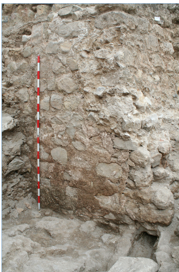
Castillo, AApré. Lienzo 10, detalle del tramo construido en mampostería trabada con mortero de yeso. Andalusi emiral.
